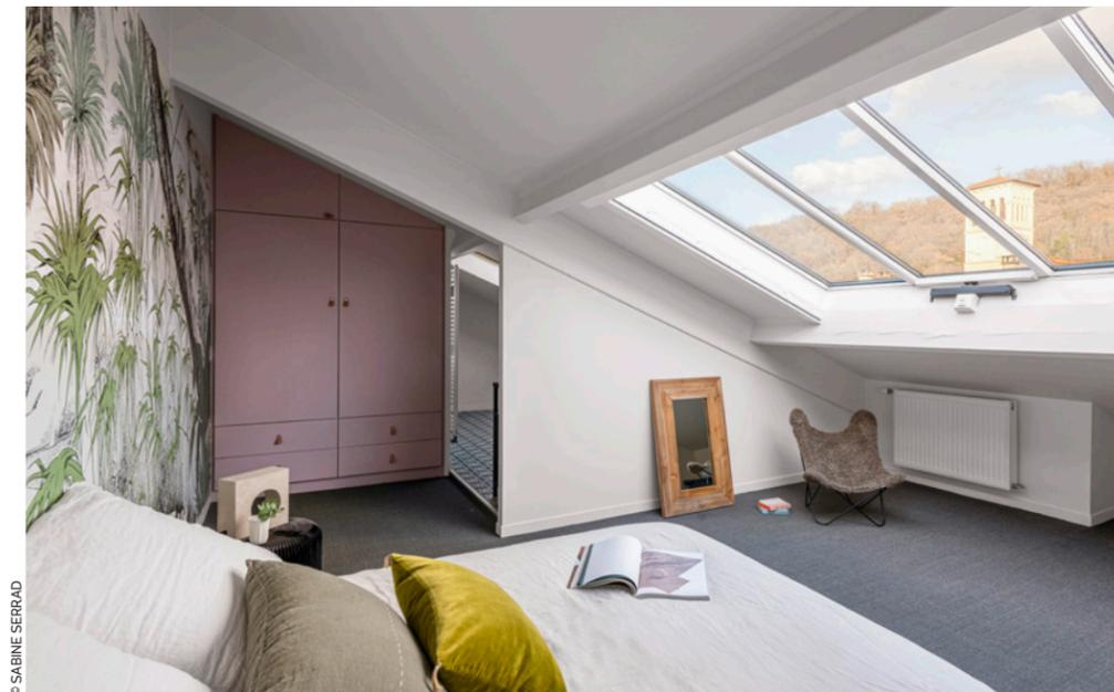
Ce comble était peu isolé et éclairé par deux lucarnes de 50 x 50 cm chacune. L'architecte Florence Monroe a préconisé une isolation de la toiture par l'extérieur et la pose d'une grande verrière « Cast » de chez Vitral (234 x 117 cm), pour en faire un cocon lumineux chaleureux.
